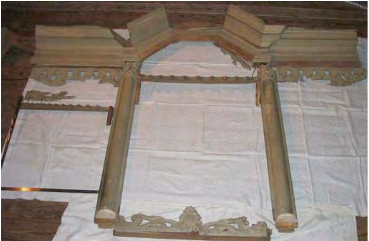
Elemente des Prospektes mit den beiden erhaltenen Pfeifenrastern; links außen eine erhaltene Prospektpfeife (Foto: Martin Schulze)
