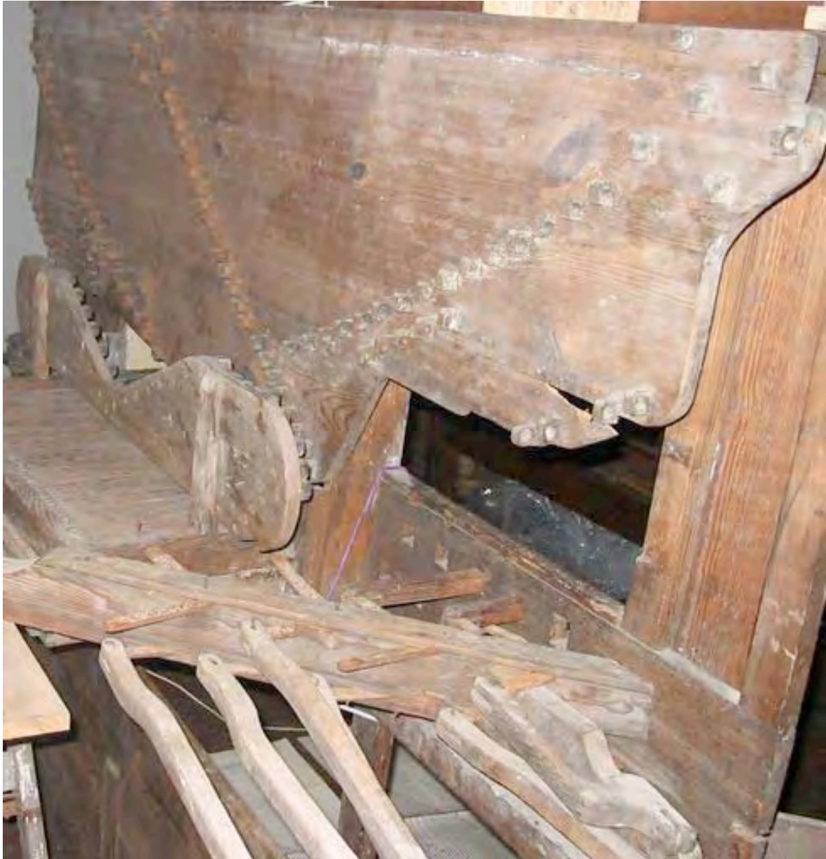
Wellenbrettanlage: Hauptwellenbrett sowie hinteres kleines Wellenbrett [unten im Bild: Registermechanik der C-Seite] (Foto: Martin Schulze)
